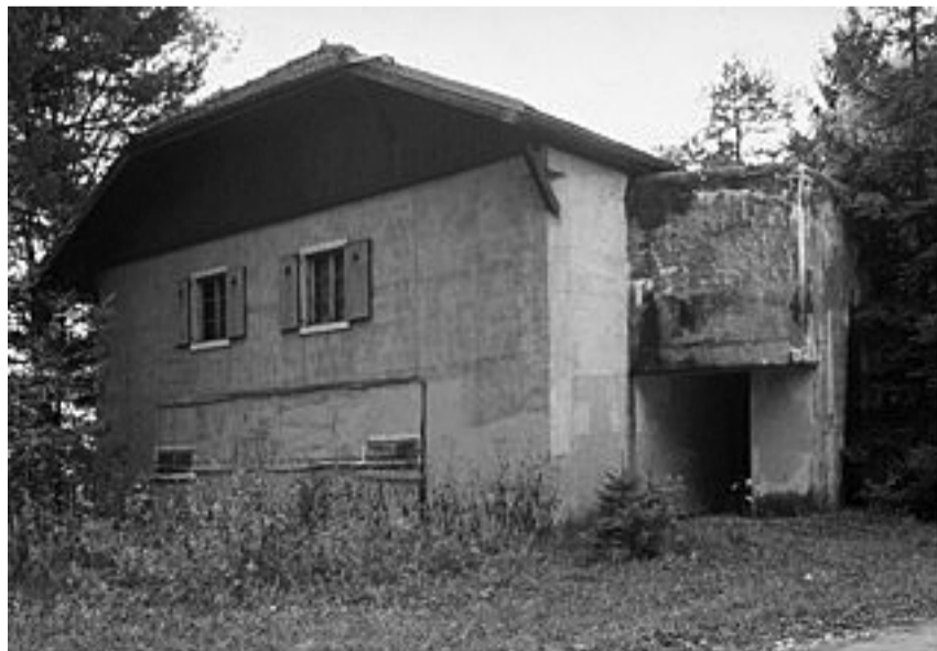
Pour la position de barrage de Lignerolle dans le Jura vaudois, le fortin «Les Rogets» fut camouflé en bâtisse civile. Bei der Sperrstelle Lignerolle, im Waadtländer Jura, wurde das Werk: «Les Rogets» als sozusagen ziviles Gebäude getarnt.
