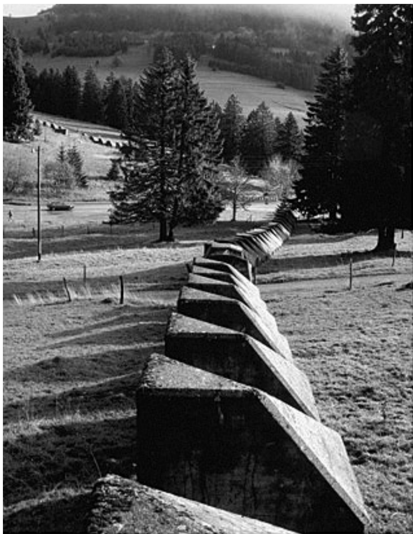
La position de barrage du Col des Etroits qui contrôlait le carrefour et la route provenant de Pontarlier contient aussi des obstacles antichars du type BBB (Bureau des fortifications de Berne).
