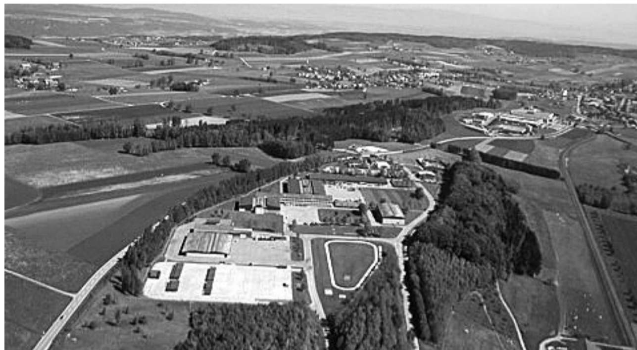
Vue aérienne de l'aire des casernes de la place d'armes de Drogens près de Romont Photo: place d'armes
