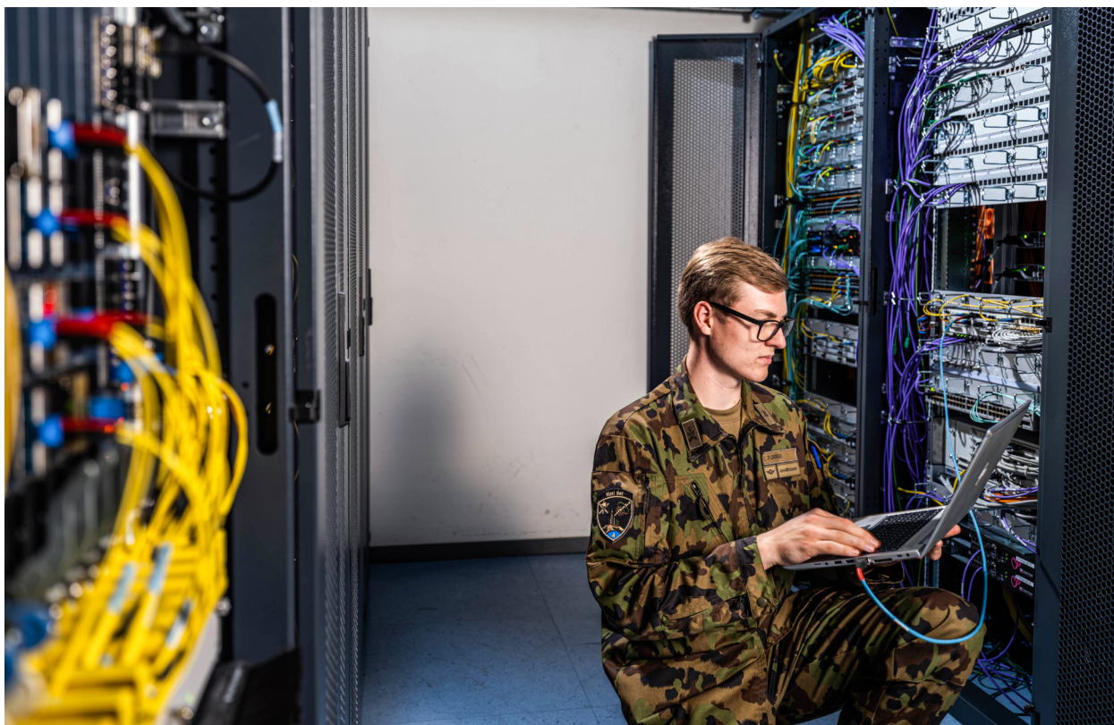
Fehlerdiagnose an optischen Datenübertragungssystemen durch Netzwerkspezialist Führungsnetz Schweiz. Copyright: Sina Guntern – VBS/DDPS
